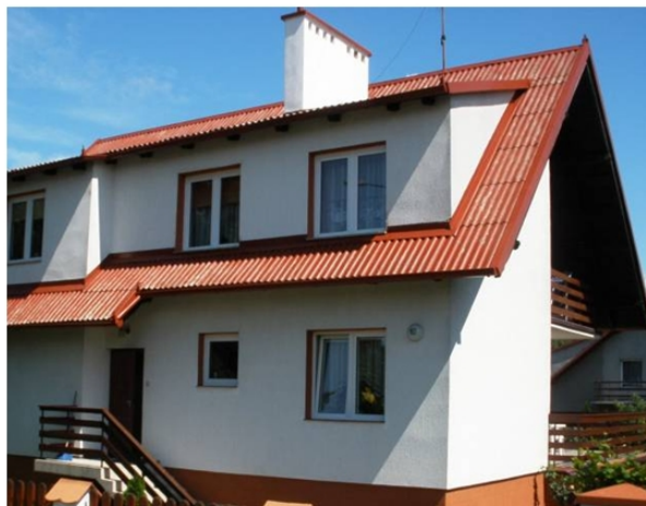
Rys. 5. Przykład zabezpieczenia wykonanego powłoką malarską.
