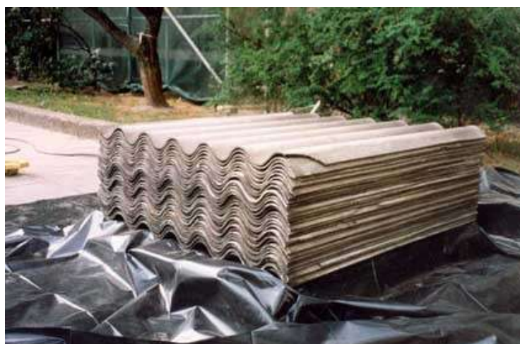
Przygotowanie wyrobów azbestowych do transportu:
