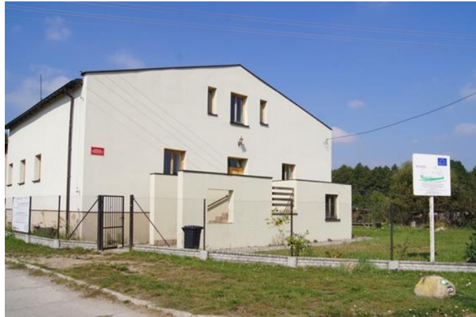
Miejsce integracji mieszkańców i kultywowania tradycji lokalnej realizowane w obiekcie zabytkowej gorzelni z adaptacją na świetlicę środowiskową we wsi Byszewy realizowaną z udziałem środków z Regionalnego Programu Operacyjnego Województwa Łódzkiego w ramach działania Odnowa wsi oraz ochrona i zachowanie dziedzictwa kulturowego
