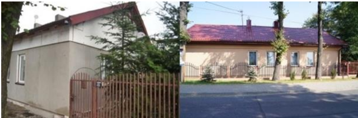
Wiączyń Dolny - ocieplany dom drewniany, który wyeliminowano z gminnej ewidencji zabytków stan w 2013 r.
