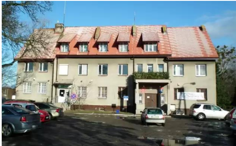
Siedziba Urzędu Gminy Nowosolna przed remontem
