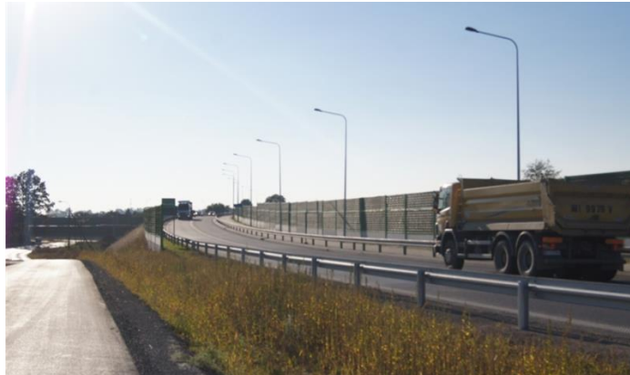
Zmiany w krajobrazie spowodowane budową autostrady
